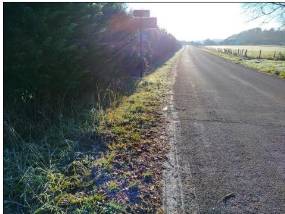
Figure 10 : Illustrations photographiques de la RD3936 en bordure est de l'emprise du projet, observée le 13/01/2022
